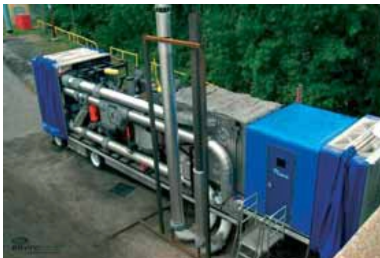
Unité mobile d'EnviroScrub Technologies fonctionnant sur le site de la Potlatch Paper Corporation
